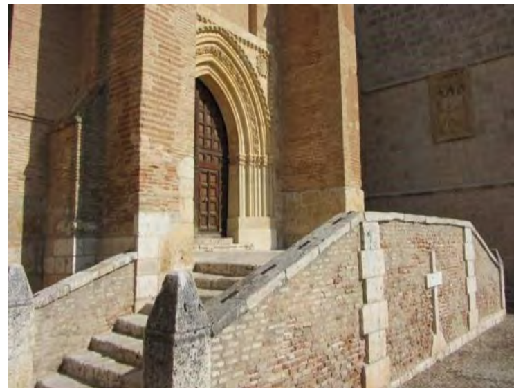
ACCESO A LA IGLESIA
