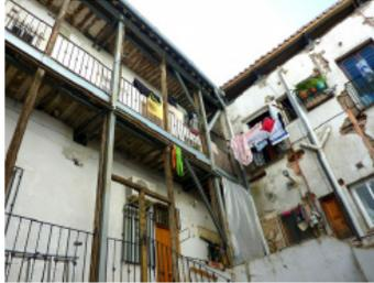
**Deficiencia:** Degradación o ausencia de aislamiento térmico en fachadas y medianerías
